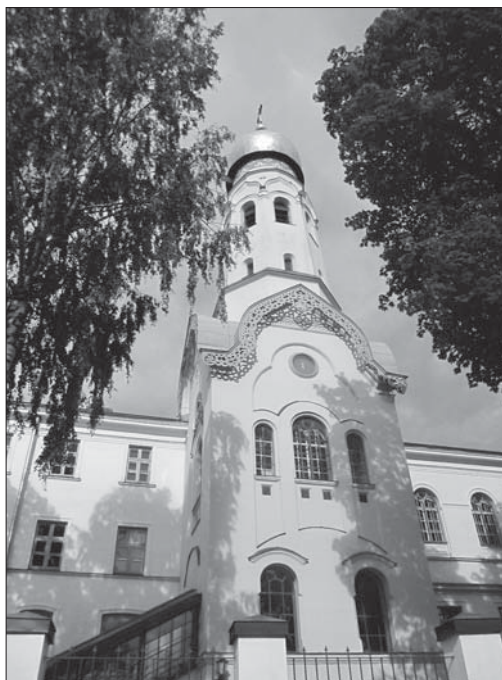
Ил. 1. Колокольня моленного дома Рижской Гребенщиковской старообрядческой общины. Постройка 1905 г. Архитектор А. Р. Шмелигин
